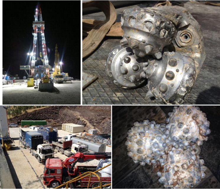
Şekil 1: Koza1 arama kuyusu sondajı; kule, çıkarılan kullanılmış matkaplar, çimento kamyonu
